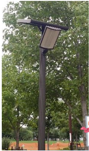
②港南緑水公園 ソーラー灯
